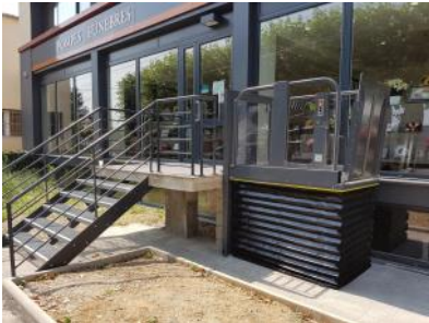
Mécanisme protégé par soufflet
